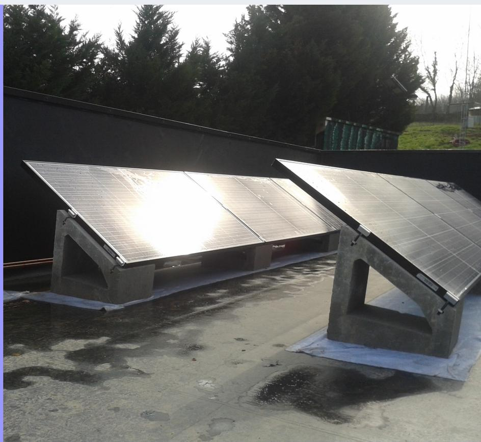
Sistema de Montaje SolarBloc, Edificio F
