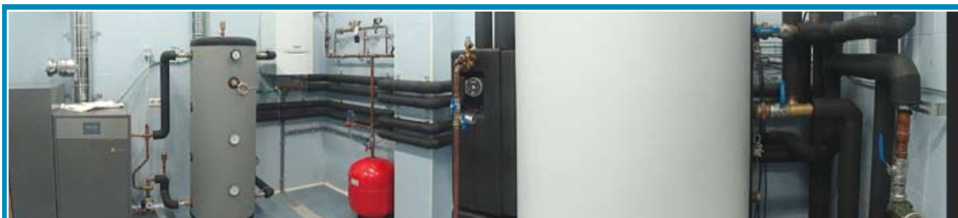
La instalación está integrada por los sistemas de microgeneración, geotermia, biomasa, energía solar y caldera de condensación.
